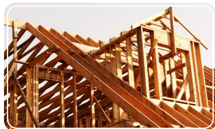
Structura cadrului folosită la construirea unei case
