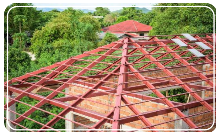
Structură din oțel realizată pentru a susține un acoperiș
