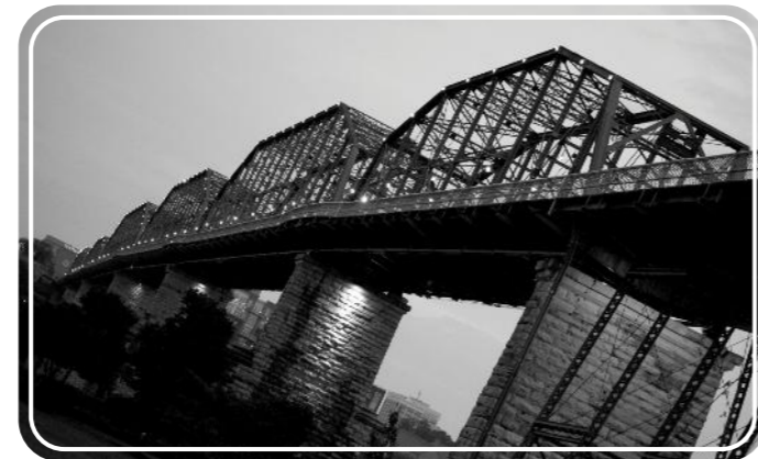
Un pod cu grinzi cu zăbrele susținute cu grinzi de sus
