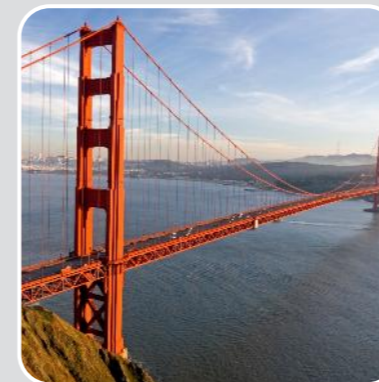
Podul Golden Gate din San Francisco este un exemplu de pod suspendat.
