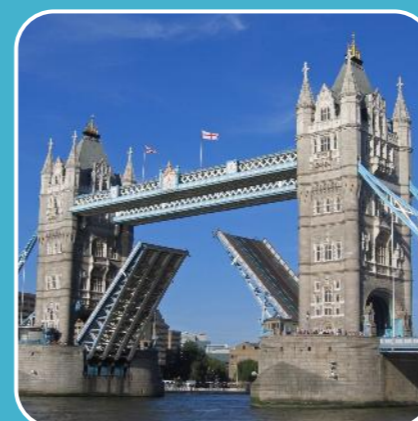
Podul Tower Bridge din Londra (Anglia)
